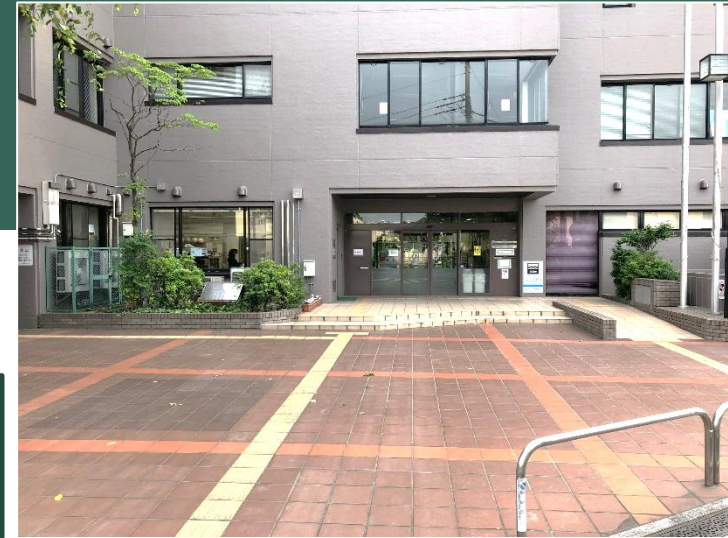
正面玄関・ 1階ロビー
