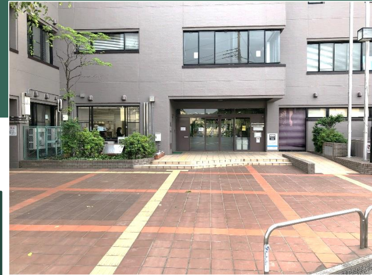
正面玄関・ 1階ロビー
